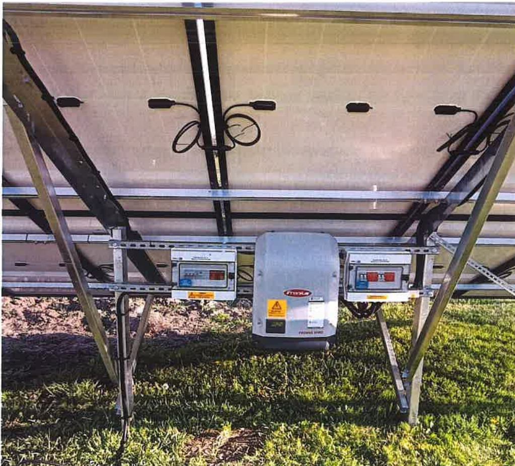
Rysunek 23. Przykładowe inwertery szeregowe zamontowane pod modułami fotowoltaicznymi.
