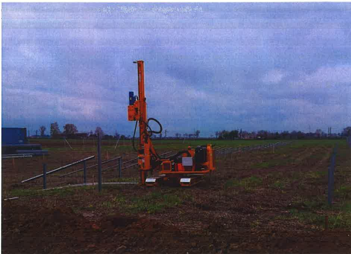
Rysunek 27. Wbijanie słupów nośnych pod konstrukcję modułów PV.
