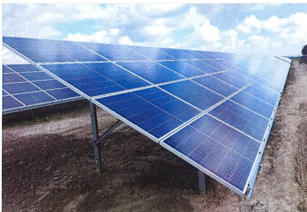
Rysunek 17. Moduły fotowoltaiczne umieszczone na konstrukcji nośnej z dwiema podporami.
